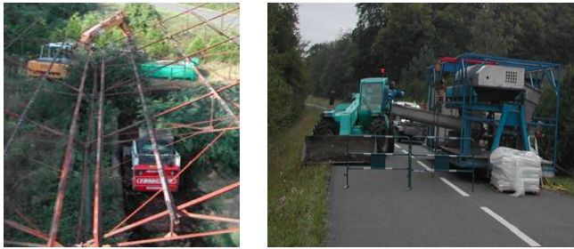
Evacuation des boues de lits de séchage et déshydratation des boues par centrifugation
