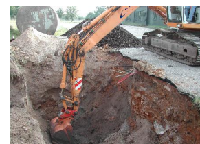
Excavation de terre polluée après enlèvement de la cuve
