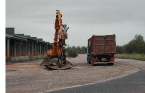
Excavation, découpage et évacuation des cuves
