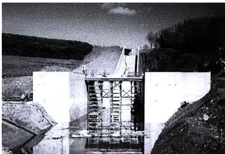
© DR - Le nouvel évacuateur de crue du barrage du Graon en Vendée
